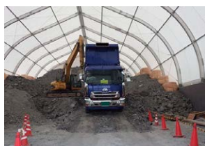
▲ トンネルずり仮置場
