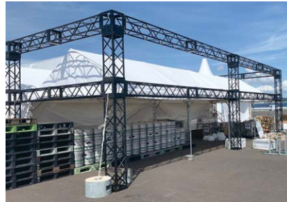
◀トラスのフレームのみ。 (サイン設置前)
