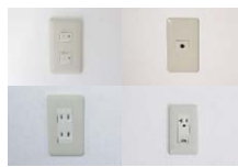
▲スイッチ、弱電配線、コンセント
