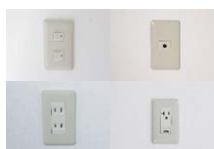
▲スイッチ、弱電配線、コンセント
