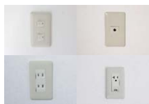
▲スイッチ、弱電配線、コンセント
